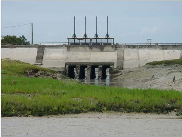
Ouvrage à crémaillère
