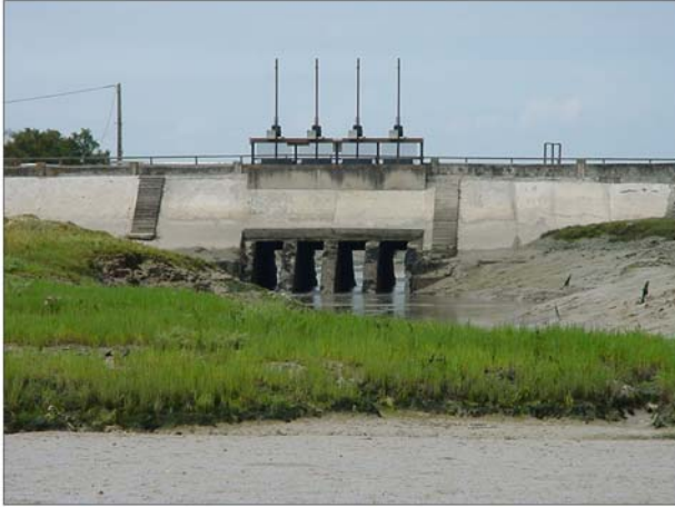
Ouvrage à crémaillère
