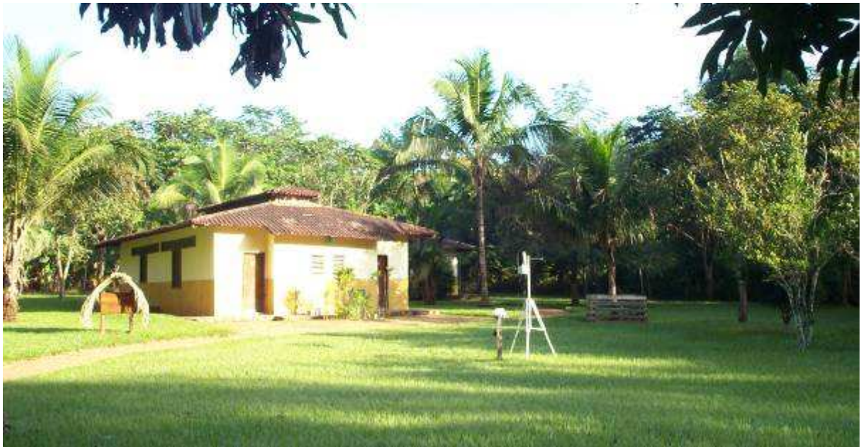
Photo 3.7 : Vue de la station Davis-WM2 installée au Cristalino-Jungle Lodge au nord d'Alta Floresta (NDVi 2 , juin 2003)
