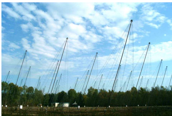
FIG. 1.12 – Les antennes log-spirales fixes du réseau décimétrique de Nançay. La direction de visée est fixée par le déphasage des signaux provenant des antennes. Les pylônes sont pointés vers l'élévation moyenne de passage des sources étudiées (Soleil, Jupiter).
