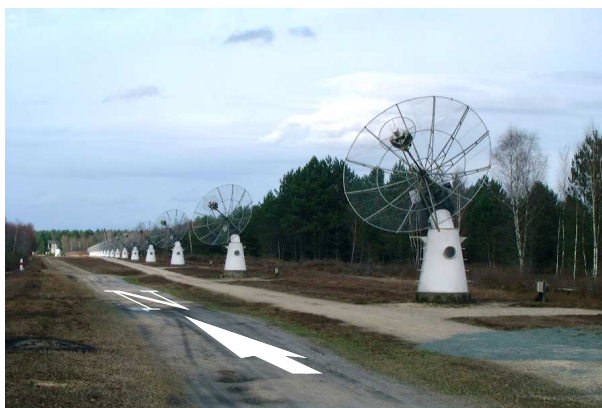
FIG. 1.14 – Antennes du bras Nord-Sud du NRH.
