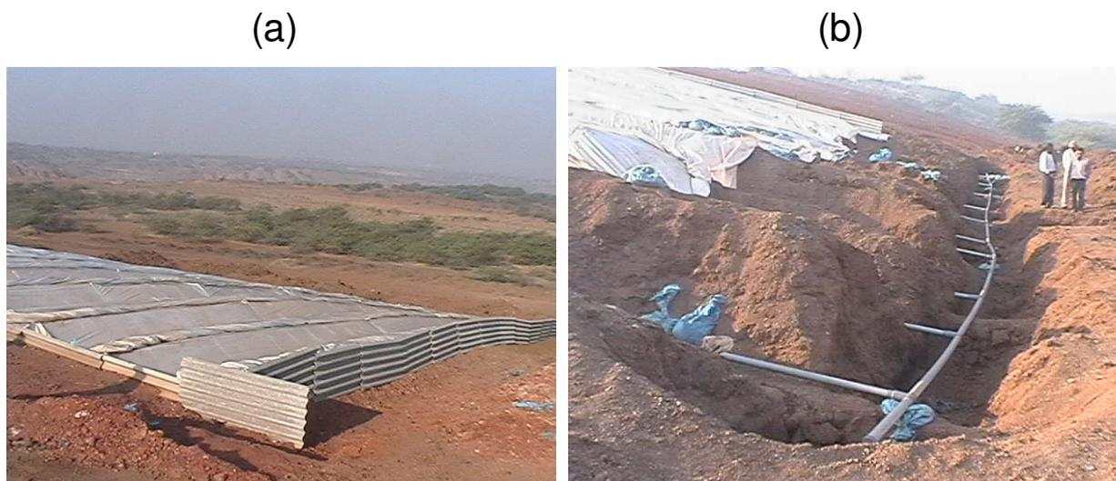
**Fig.IV.17.** (a) Perspective sur les 10 premières rangées complétées (soit 850 m<sup>2</sup>). (b) détail sur le réseau de collecte des eaux de chaque rangée. (photo S. Singh).
