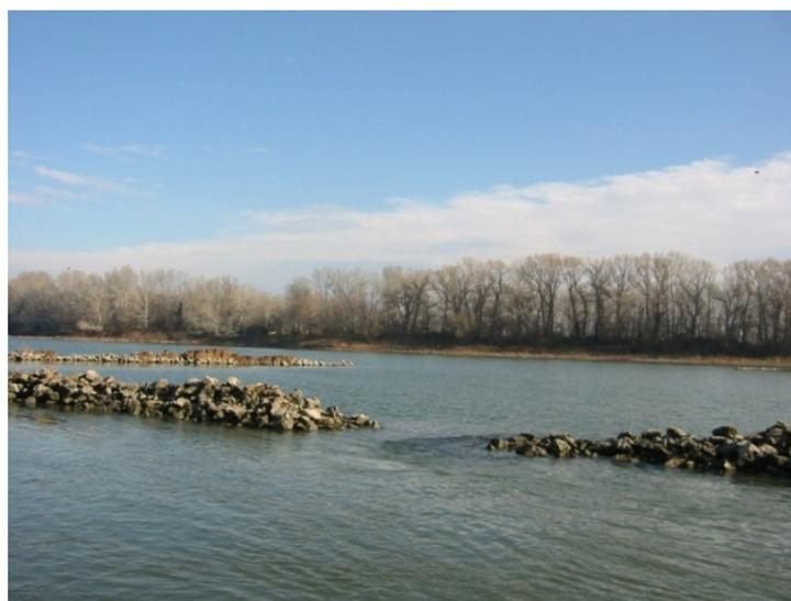
Photo 4 : Le casier de Saxy en amont de la diffluence (rive gauche). La distance entre la digue et la berge est de 200 m (grand casier, photo Raccasi)
