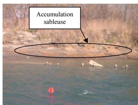
**Photo 7 : Accumulation de sable en pied de berge en arrière d'un panneau de fond affleurant à l'étiage (Photo Raccasi)**
