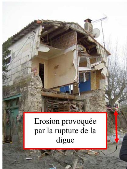
**Photo 12 : L'ancienne maison du garde digue en pied de digue, partiellement détruite par la création de la brèche. En arrière plan l'érosion provoquée par la brèche (Cete-Méditerranée. et CEMAGREF, 2004)**
