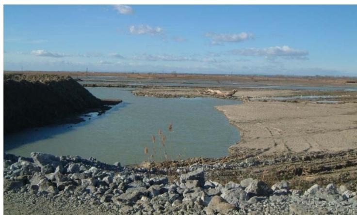
**Photo 13 : Erosion en aval de la digue. La surface en eau représente la zone d'érosion maximale, Vue prise depuis la digue reconstruite (Photo IRSN)**
