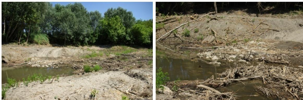
Photo 2 : Mise à jours d'un seuil enseveli sous les sédiments dans la lône du Pillet en 2007, pendant des travaux de restauration de la lône par la CNR (Photo Raccasi)
