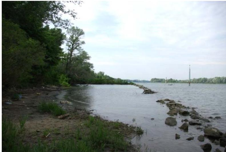
**Photo 3 : Le casier de Farragon, en amont de la diffluence (rive droite). La digue est quasiment intégrée à la berge par sédimentation dans le casier (petit casier, photo Raccasi)**
