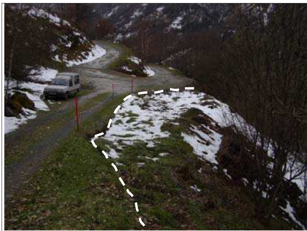
Figure 22 : Photographie d'un début de glissement de terrain au mois de Mai 2004.
