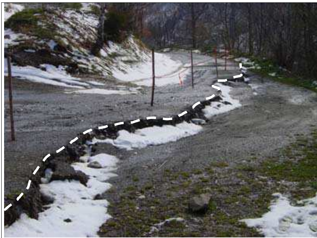
Figure 21 : Photographie d'un escarpement réactivé au mois d'Avril 2003.
