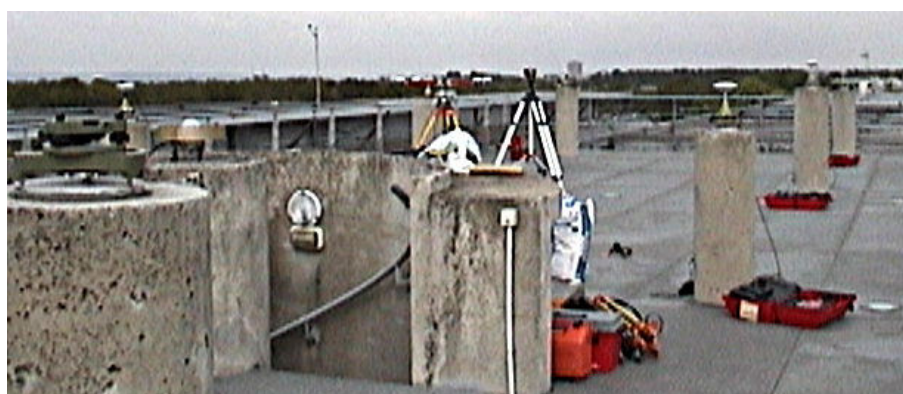
FIG. 3.18 – Vue du chantier pour les mesures GPS et de topométrie.
