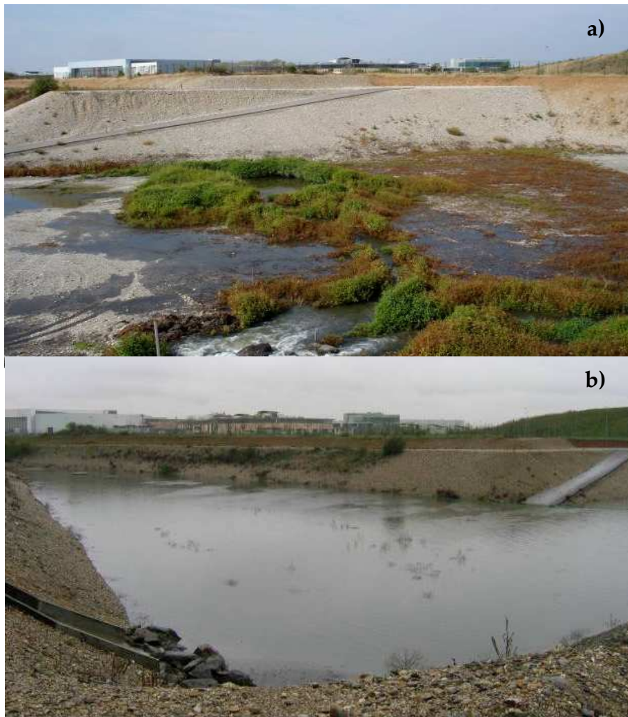
Figure A-3 : Bassin d'infiltration de Django Reinhardt à vide (a) et en eau (b)
