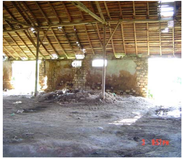
Figure 16 : L'intérieur du dépôt
