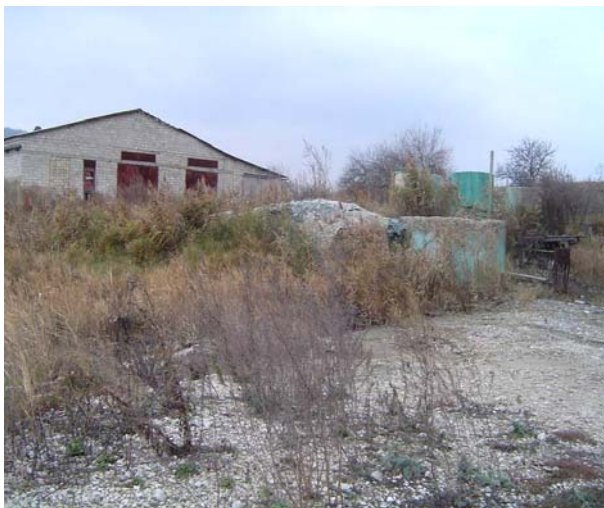
Figure 23 : Dépôt et station de préparation du village de Sadova
