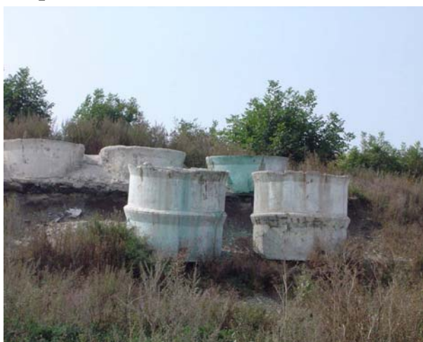
Figure 19 : Station de préparation de Biesti
