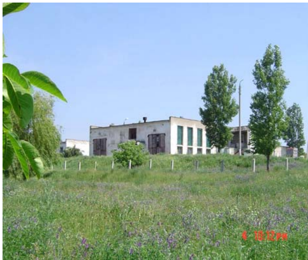
Figure 13 : Dépôt du village de Cuhnesti
