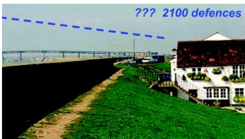
Figure 3.62 : Le pub aujourd'hui. Les digues surélevées après l'inondation de 1953 puis en 1980 arrivent au niveau des avants toits (Source Agence de l'Environnement).
