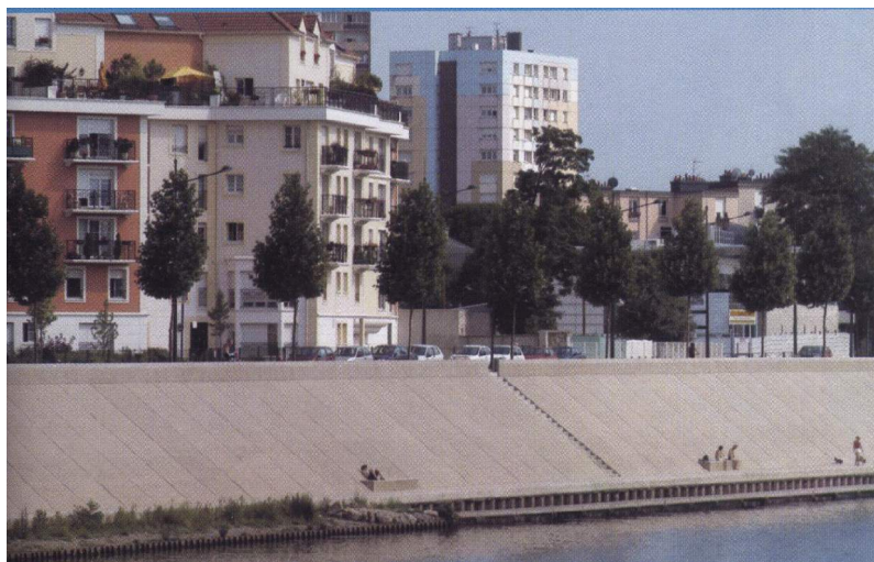
Figure 1.23 : Les murettes anti-crue du quai Blanqui à Alfortville (Source : plaquette d'information de la commune)
