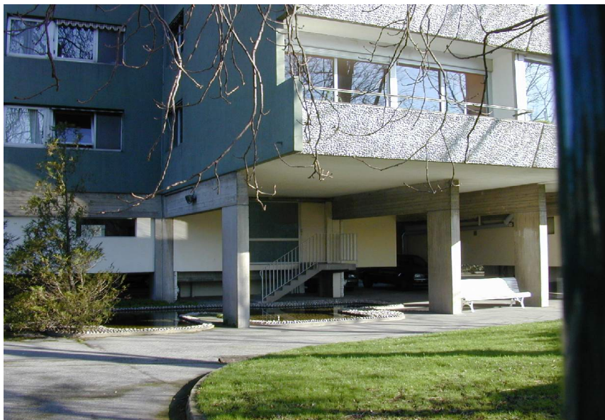
Figure A.20 : Champigny-sur-Marne, exemple de bâti des quartiers des bords de Marne du centre-ville (Cliché : M. Segard, 2005)
