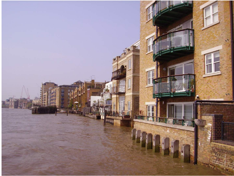
Figure 3.28 : L'accès à la Tamise est réservé aux résidents des logements réhabilités ou reconstruits en front de fleuve. (Cliché S. Beucher, avril 2007)
