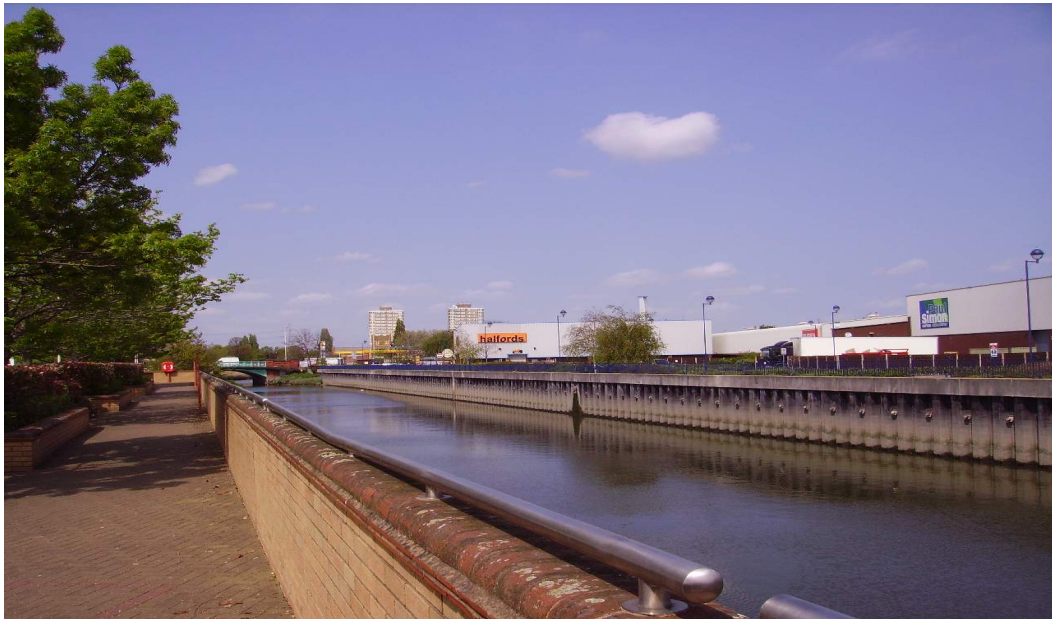
Figure 3.38 : La rivière Roding canalisée. (Cliché S. Beucher, avril 2007)
