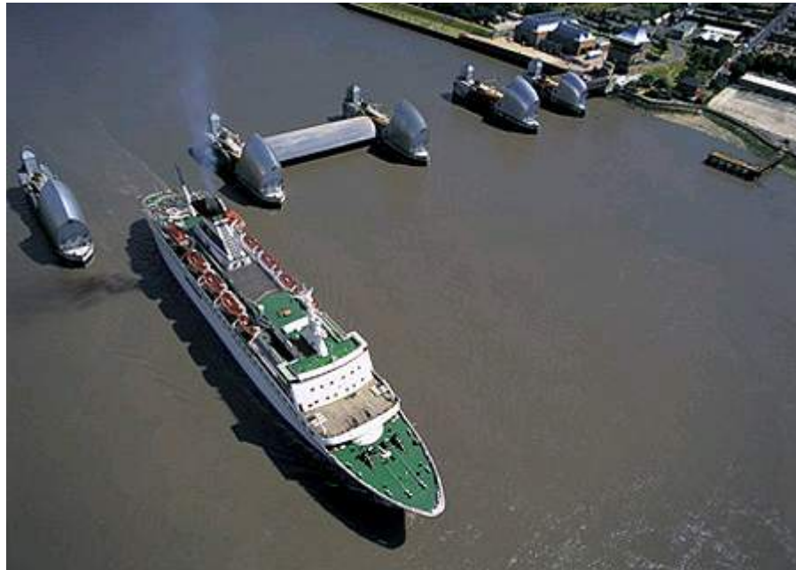
Figure A.5 : En position ouverte, la Thames Barrier permet le passage des bateaux (Source : BBC).
