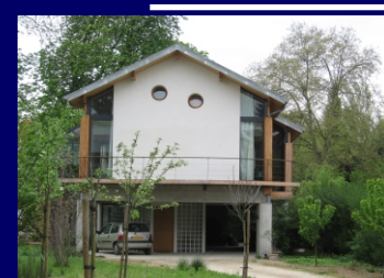
Habitat individuel sur pilotis à Créteil
