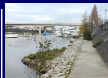
Berges et murettes à Nogent
