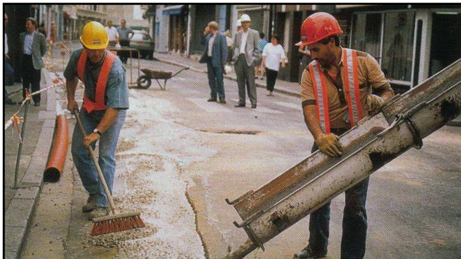
**Figure 3 :** Mise en œuvre d'un remblai autocompactant
