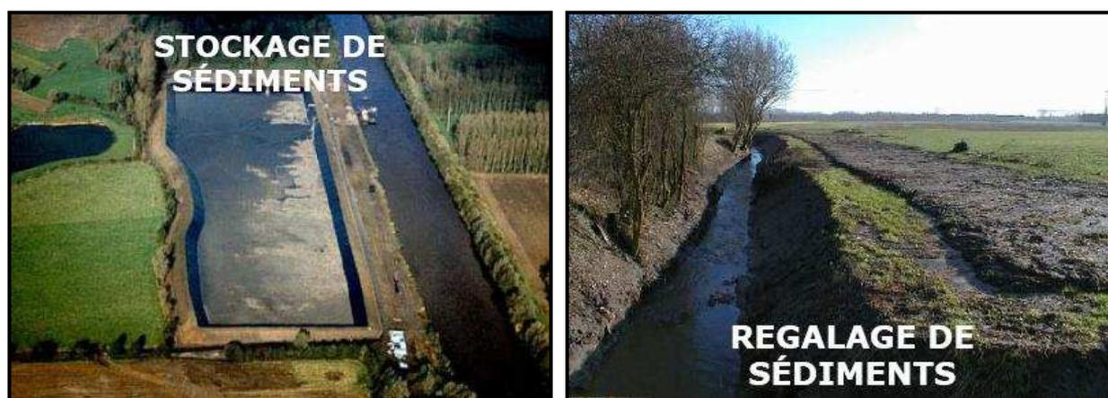
**Figure 4 :** Stockage et régilage des sédiments fluviaux
