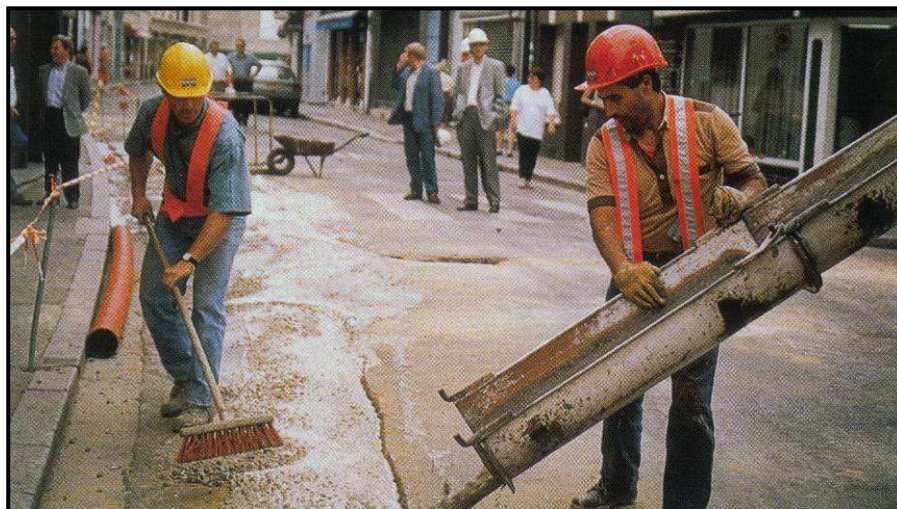
Figure 3 : Mise en œuvre d'un remblai autocompactant
