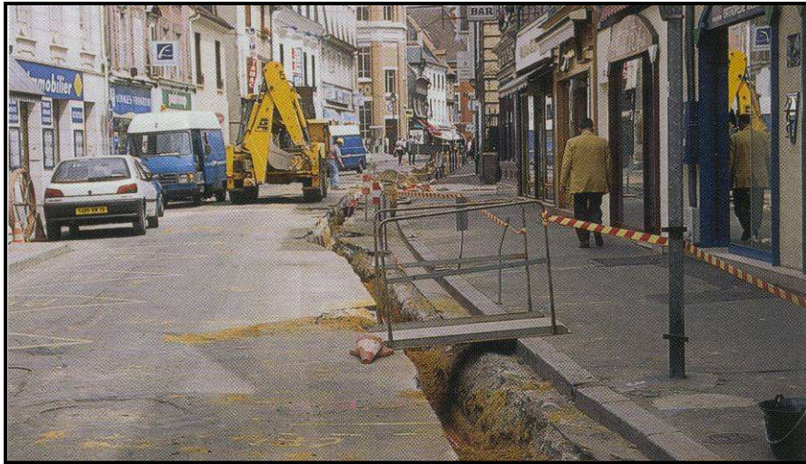
Figure 1 : Ouverture de tranchée de faible largeur en milieu urbain
