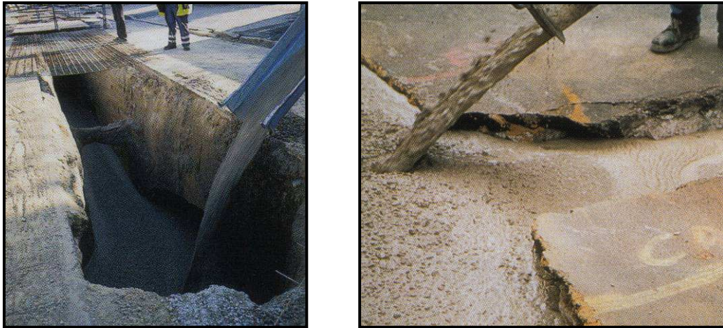
Figure 2 : Remplissage de tranchée avec un remblai autocompactant par simple déversement
