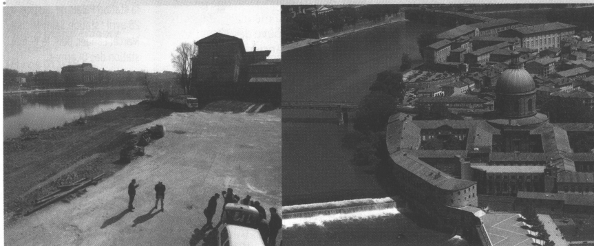
Les travaux ont commencé et la nouvelle passerelle Viguerie offrira fin 2007 une vue exceptionnelle sur le fleuve.
