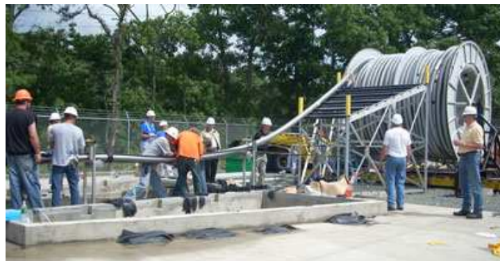
Figure 1.16 Mise en place du câble supraconducteur de puissance du projet LIPA, Nexans [Nex08]
