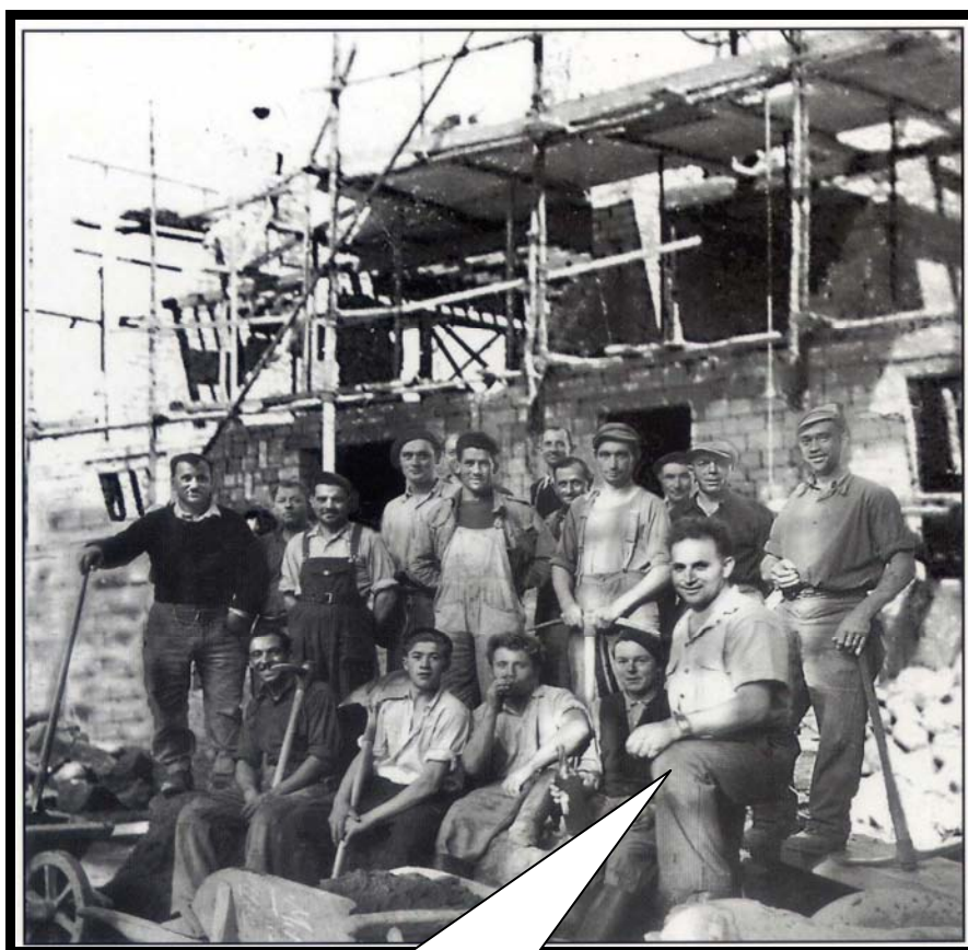
mon père Aldo Da Rold sur un chantier de la reconstruction de Vire (14), entreprise Borsa – Dorival.
