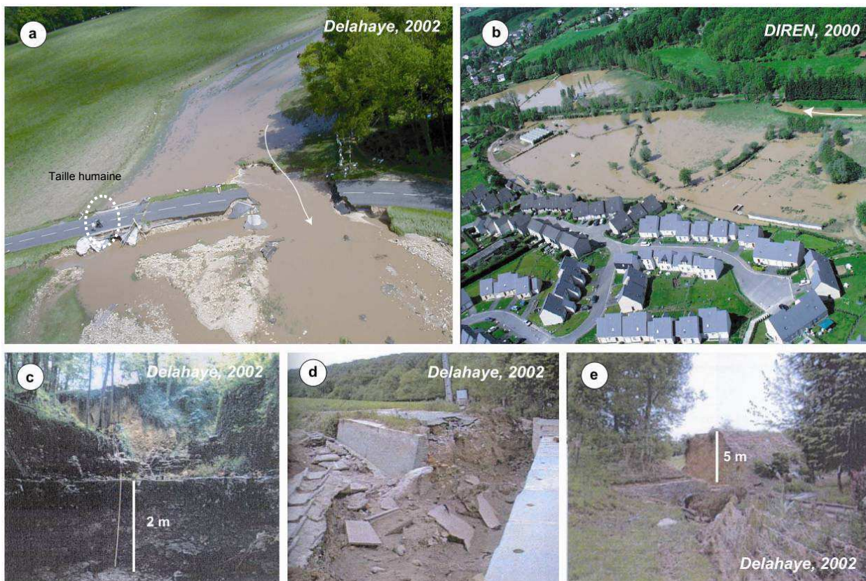
Légende: a) Route entaillée sur 2 m de profondeur et plus de 10 m de large (exutoire du bassin de St-Paer) ; b) la majorité des écoulements turbides ont ensuite alimenté les eaux de l'Austreberthe, qui se raccorde à la Seine en arrivant à Duclair ; c) incision à 1km en amont de l'exutoire du vallon sec de St-Paer : mise à jour du substrat crayeux et entailles > 2m de profondeur ; d) et e) rupture du tablier routier sur la route qui traverse le bassin sur près de 5 m de hauteur. Document réalisé par J.Douvinet
