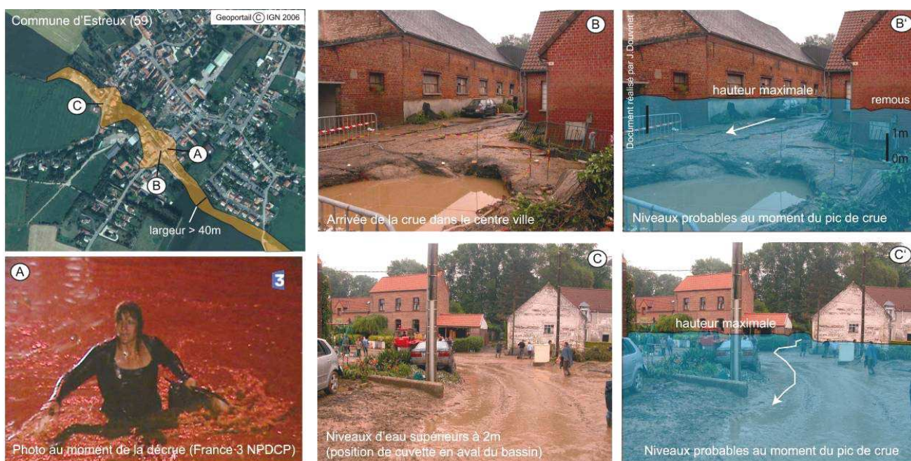
Fig. 2.8. Quelques photos des dégâts et estimations des niveaux probables atteints lors de la crue rapide du 7 juin 2007 sur le bassin versant d’Estreux (59) (Douvinet et al. , 2008).
