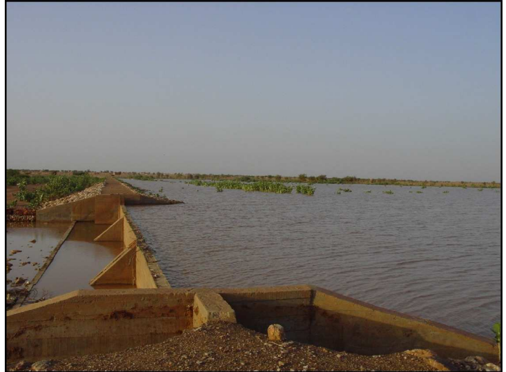
Photo 1 : Barrage sur le bassin versant d'Aleg (31/08/06)
