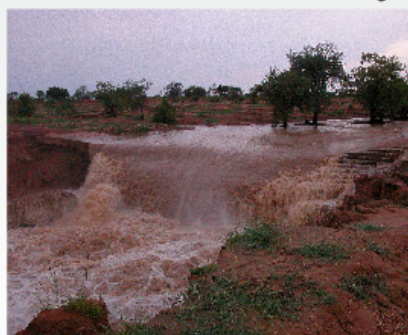
Destruction des routes et des digues à Ounjougou (2007)
