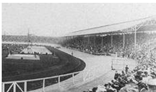
Figure 24 : Poteaux supportant la toiture du Stade White City à Londres
