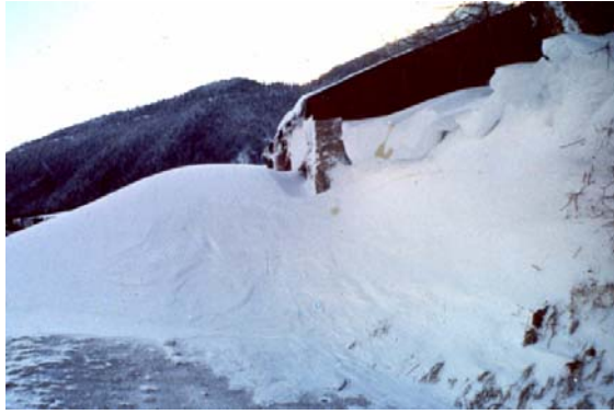
Congère générée par un bâtiment, photo Frédéric Ousset, Cemagref
