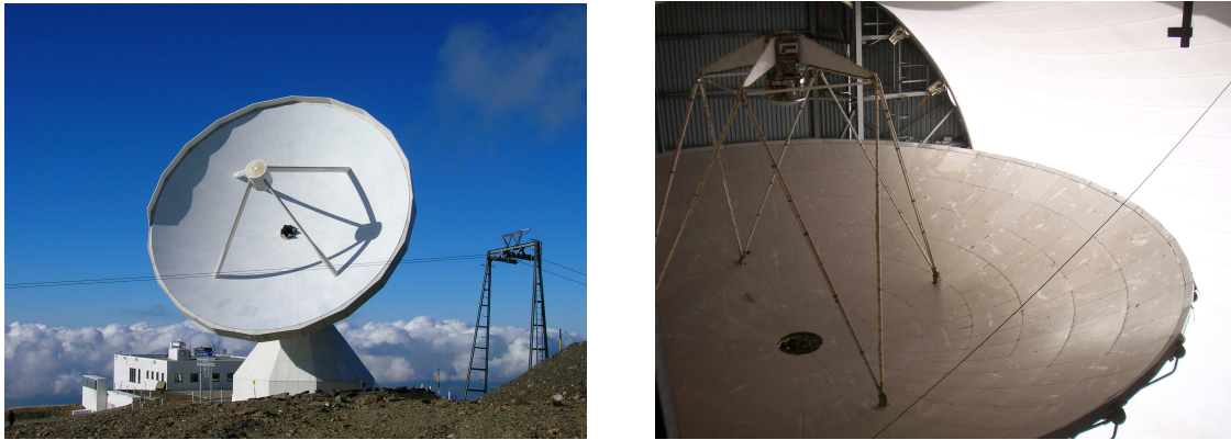
FIG. 2.1: Exemples de télescopes qui observent dans les domaines millimétrique et submillimétrique. Sur la photographie de gauche, on peut voir l'antenne de 30 m de l'Institut de RadioAstronomie Millimétrique (IRAM) à Grenade, en Espagne. L'image de droite est une photographie des miroirs primaire (15 m de diamètre) et secondaire du James Clerk Maxwell Telescope (JCMT). Le miroir primaire est composé de plusieurs panneaux qui peuvent être ajustés individuellement pour améliorer la précision de la surface. Sur la droite de cette image se trouve le film de gortex qui protège l'installation de la poussière volcanique extérieure. En effet, ce télescope (et de nombreux autres) est construit au sommet du volcan Mauna Kea. Le film protecteur est transparent aux radiations millimétriques et submillimétriques. (Photographies réalisées lors des observations de Saturne et d'Uranus en septembre 2006 à l'IRAM et des observations de Saturne en janvier 2008 au JCMT).
