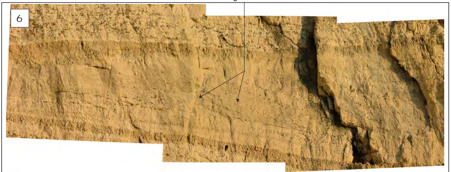
Planche 2: Géométries observées dans le Panorama Ouest Porte d'Amont (positions indiquées sur la figure D.8) 4: Géométrie en chenal en base et au sommet, la première géométrie en chenal est surmontée par des faciès conglomératiques à blocs, la seconde est érodée à son sommet. 5: Banc de silex slumpé et faciès bréchique. 6: Mégarides 2D en direction du Sud-ouest.
