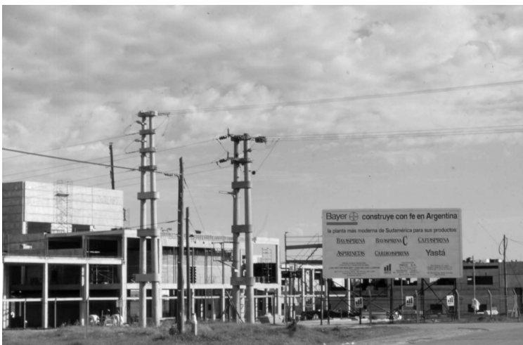
Usine en construction dans le parc industriel de Pilar à la limite nord de l'agglomération.
