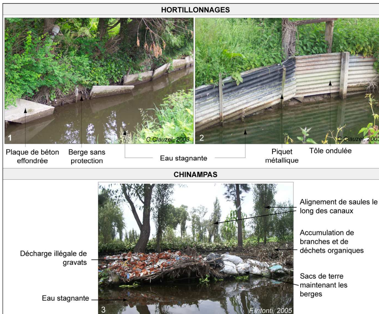
Planche 14 : Renforcement des berges par des matériaux non adaptés dans les hortillonnages (n° 1 et n° 2) et dans les chinampas (n° 3). La diversité des propriétaires et des gestionnaires complexifie la coordination des actions de restauration et d'entretien des sites. Certaines zones ne sont ainsi plus du tout entretenues et lorsqu'elles le sont, les techniques de renforcement des berges varient d'une parcelle à l'autre avec l'utilisation de matériaux divers, plus ou moins écologiques.
