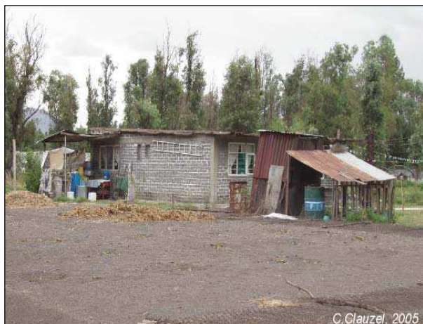
Photo 8 : Habitat précaire et irrégulier à San Gregorio Atlapulco. Si l'habitation est construite en parpaings de ciment, le toit et l'appentis ont été réalisés avec des matériaux de récupération. En arrière-plan, des saules en alignement sont visibles sur les berges d'un canal. L'espacement des arbres à gauche témoigne d'une probable exploitation ou d'une dégradation de leur état phytosanitaire.
