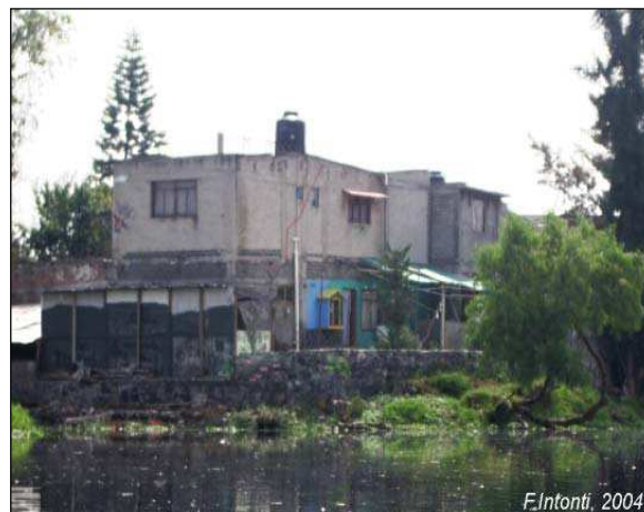
Photo 9 : Habitat irrégulier en matériaux durs à Tláhuac. Ce type de construction dispose souvent d'un toit inachevé. Le propriétaire se réserve ainsi la possibilité de surélever sa maison en créant un étage supplémentaire dans le cas où celle-ci soit régularisée. Sur cette photographie, un réservoir pour le gaz raccordé à l'habitation par un tuyau rouge est également visible sur le toit.
