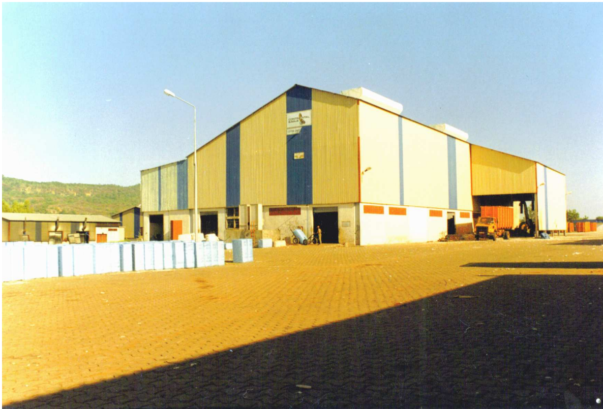
Photographie n°24 : usine d'égrenage de Kita, 2003.
