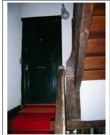
Escalier du N°15 rue Ferdinand Le Dressay (Hôtel Desruisseaux) 2 nd e ½ du XVIIIe siècle.
