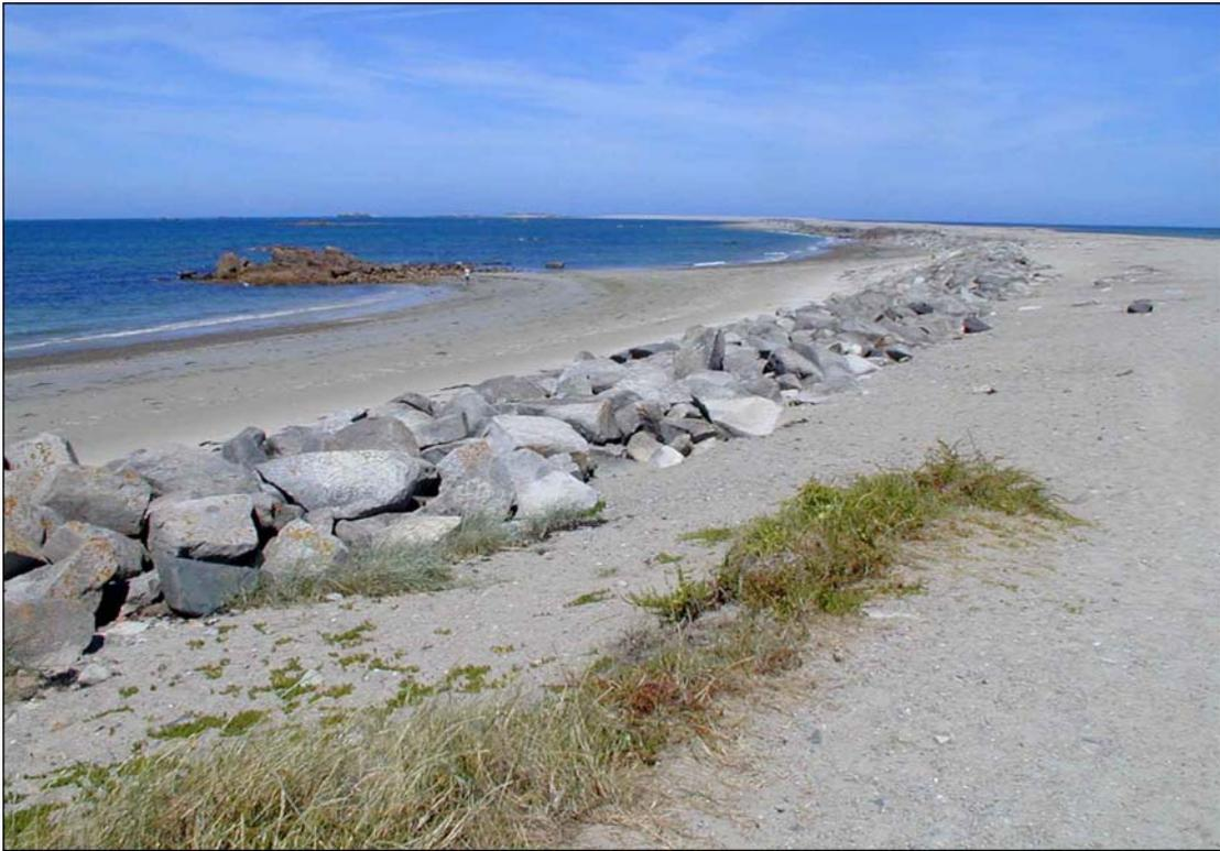
Photographie 41 : Digue frontale en enrochements mise en place en haut de cordon le long du Sillon de Talbert (Cliché : D. Halleux, 2003).
