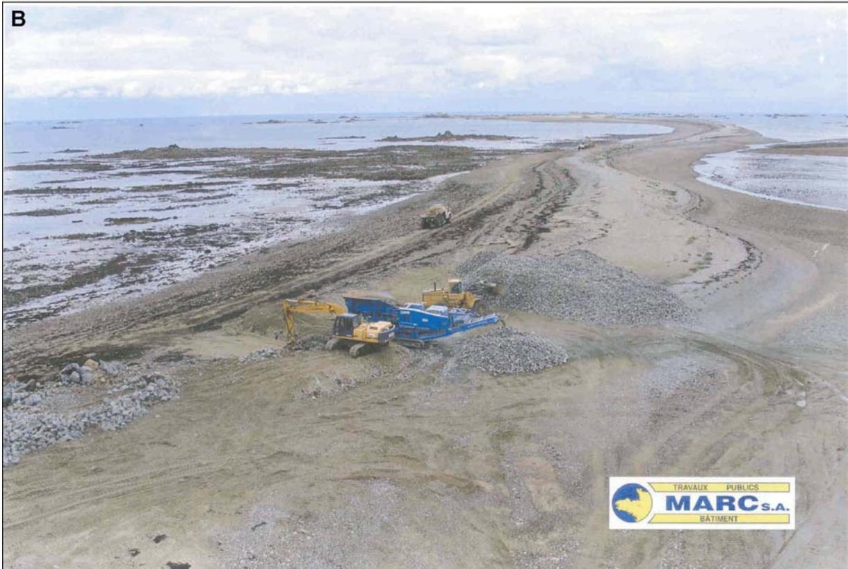
Photographie 42 : Travaux de suppression de la digue frontale en enrochement sur le Sillon de Talbert (cliché A : D. Halleux, octobre 2004 ; cliché B : Société Marc)
