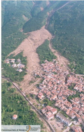
F . 1.5 – Aperçu des coulées de boue torrentielles qui ont détruit une bonne partie de Quindici le 5 mai 1998.
