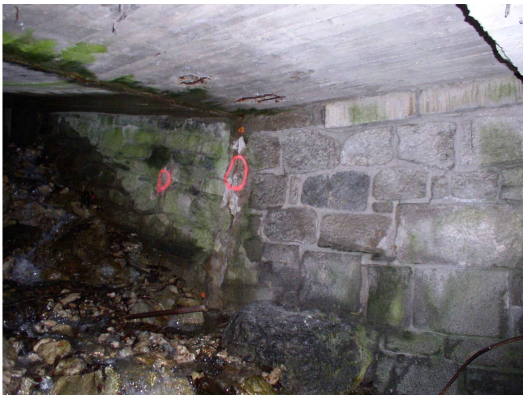
F .4.16 – Pont de la route sur le ruisseau de Ballendaz.
