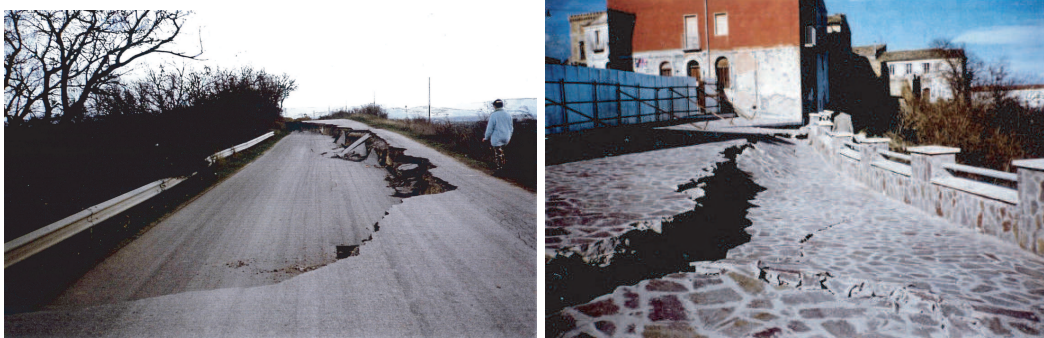
F . 1.4 – Exemple de dégâts causés par le glissement de terrain de Petacciato en 1996.
