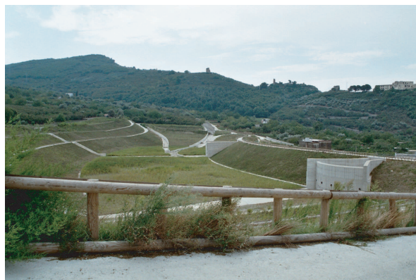
F . 1.6 – Ouvrage géotechnique construit à la suite de cet évènement (source personnelle).
