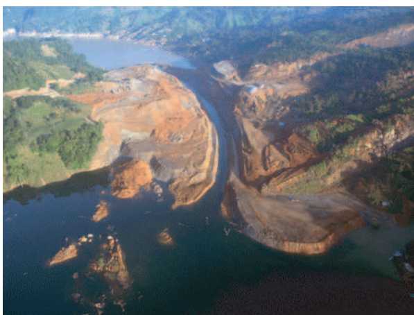
F . 1.8 – Évolution des travaux d'excavation permettant la remise en service du fleuve et de ses installations hydroélectriques. Photos actuellement disponibles sur : www.cfe.gob.mx .
