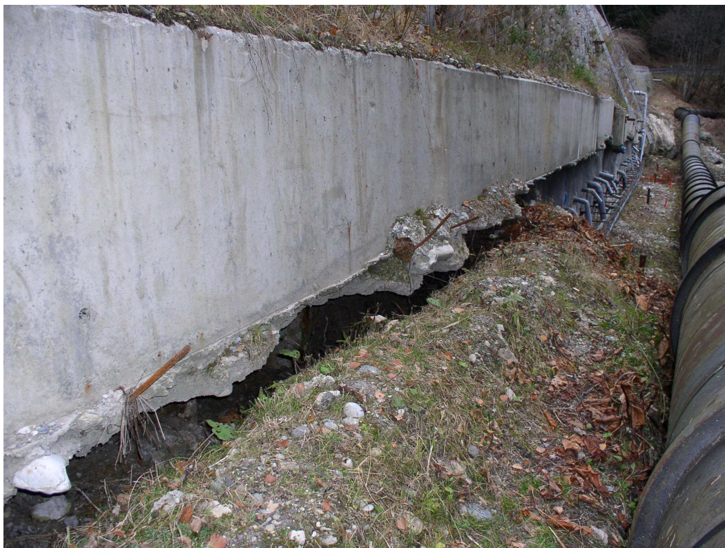
F .4.15 – Conduite forcée EDF sous la route.
