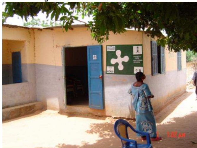
Figure 29: Vue des locaux du centre Aden
