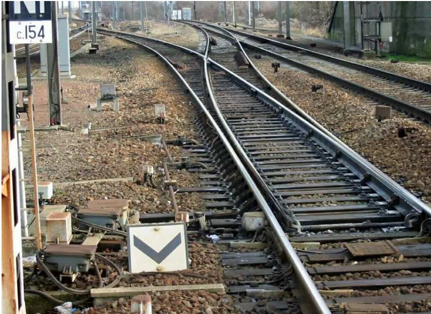
FIGURE 2.1. Aiguillage simple en gare d'Épône. Photo JH. Mora, janvier 2005, GNU Free Documentation License v1.2
