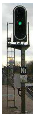
(b) Signal lumineux ouvert « voie libre »
