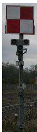
(a) Signal mécanique fermé, « carré »
