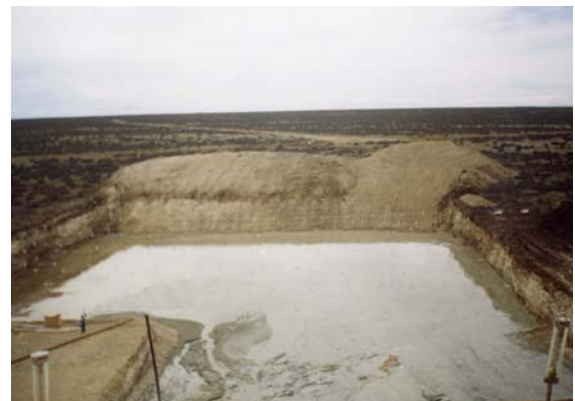
91. Bassin de boue de forage
