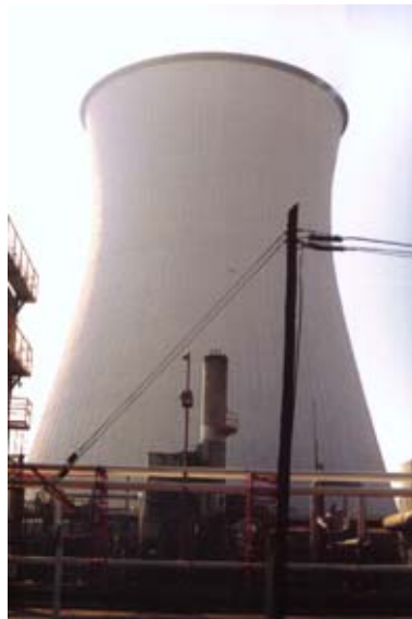
112. Tour de refroidissement
