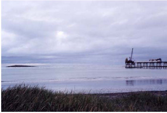
33. Construction paralysée du port de Río Grande
