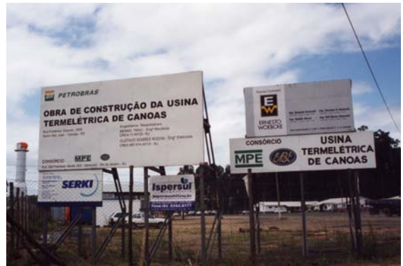
20. La centrale à gaz Termocanoas en construction
