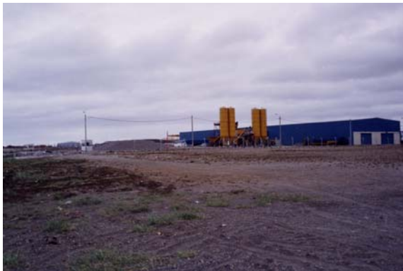
35. Chantier du port de Río Grande
