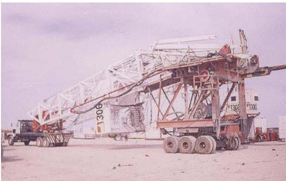
92. Montage d'une tour de forage
