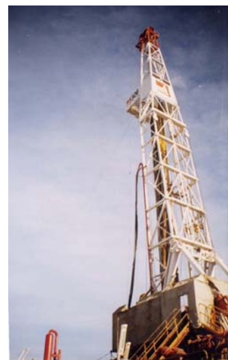
93. Tour de forage
