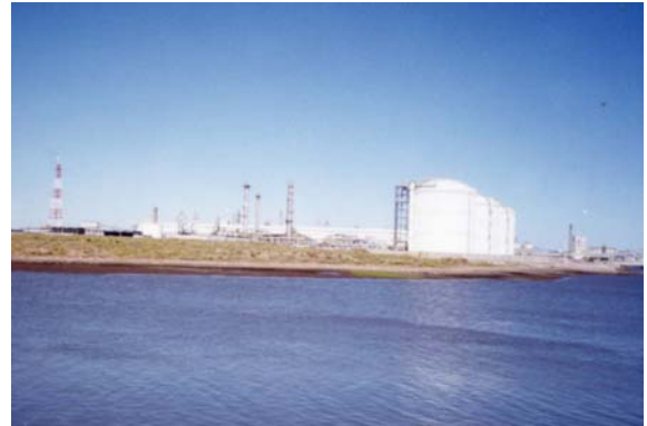
89. Les installations de stockage d'YPF
