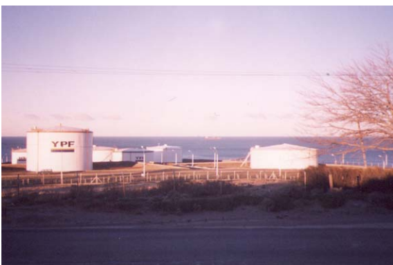
99. Le terminal de combustible
