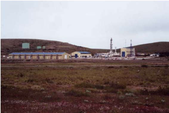
64.Installations de Posesión
