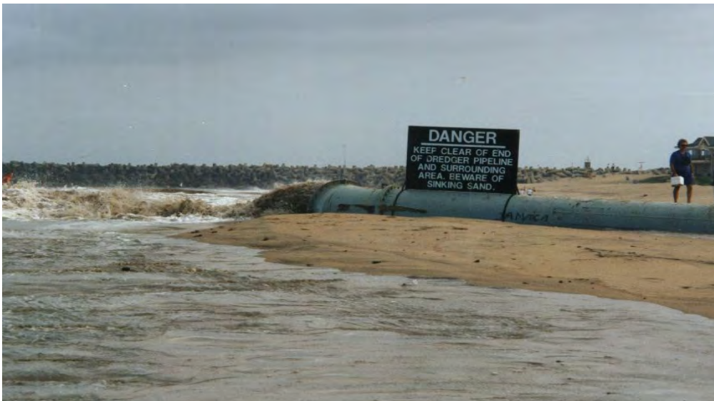
Photo 77 : L'exutoire de la conduite de dragage sur la plage publique à Richards Bay
