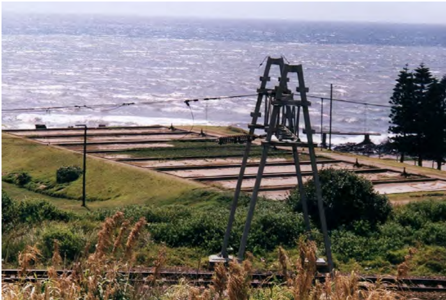
Photo 42 : Les bassins de décantation sur le front de mer
