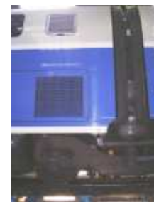
c. espace entre deux caisses
