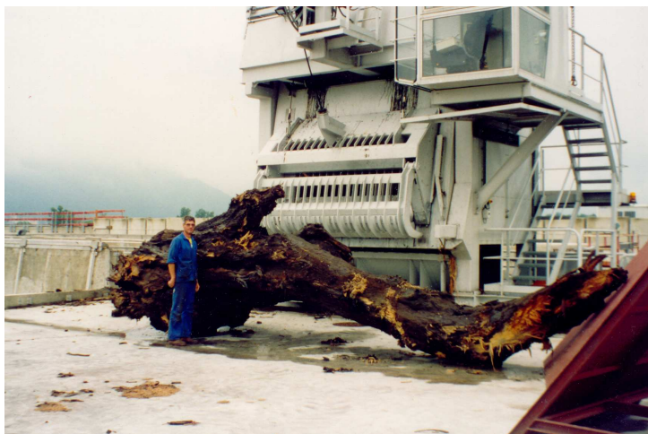
Photographie 4 – Le dégrilleur du barrage de Saint-Egrève (cliché : EDF Energie-Alpes, 2001).
