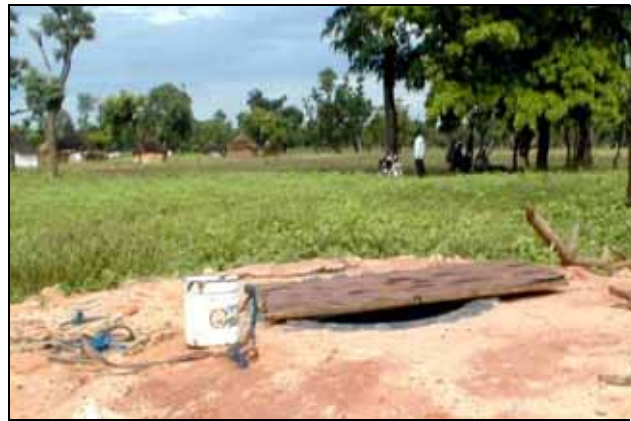
Photo 24. Puits ouvert à Laïndé Ngobara
