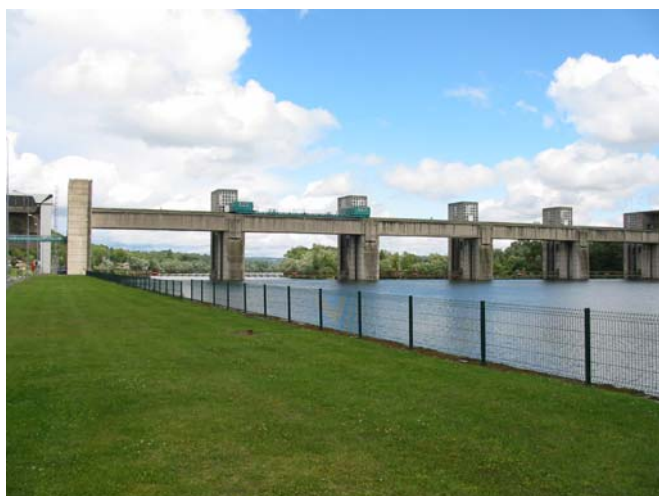
Figure 11 : Site du barrage de Méricourt (vue amont juillet 2007)
