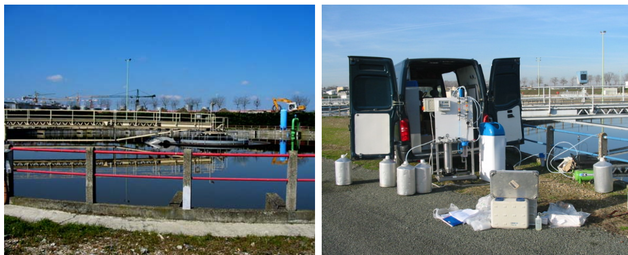
Figure 8 : STEP Seine-Aval à Achères, décanteur secondaire (à gauche tranche 3 le 6 avril 2006 et à droite tranche 4 le 15 décembre 2006)
