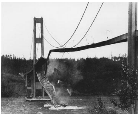
(a) Pont de Tacoma Narrows au moment de l'effondrement sous l'effet du vent (source : http://www.egretnest.files.wordpress.com )
