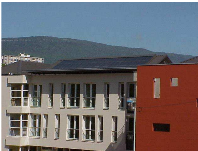
Figure 85 : Façade sud des Berges de l'Hyères
