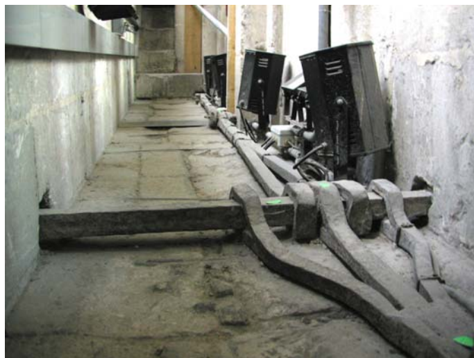
Figure 2.24 : a. Vue du triforium de la cathédrale d'Amiens et b. Ancrage du chaînage au niveau de la nef. Crédit photos L. Bellot-Gurlet.
