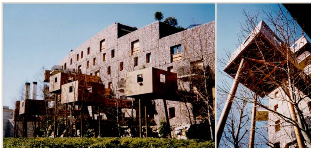
Illustration 44 : L'immeuble qui pousse ou l'immeuble Robinson, rives du Lez, Montpellier Pardo, C., 2005
