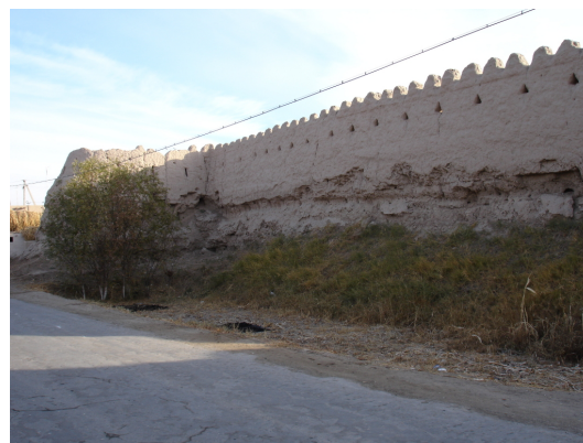
(b) Face externe de la muraille : mur de bauge.
