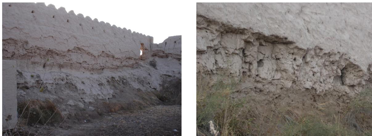
(a) Vue générale de la base du mur.
