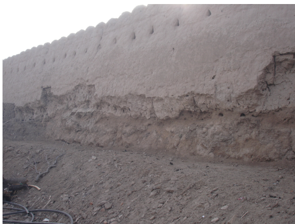
(a) Partie externe : mur de bauge.
