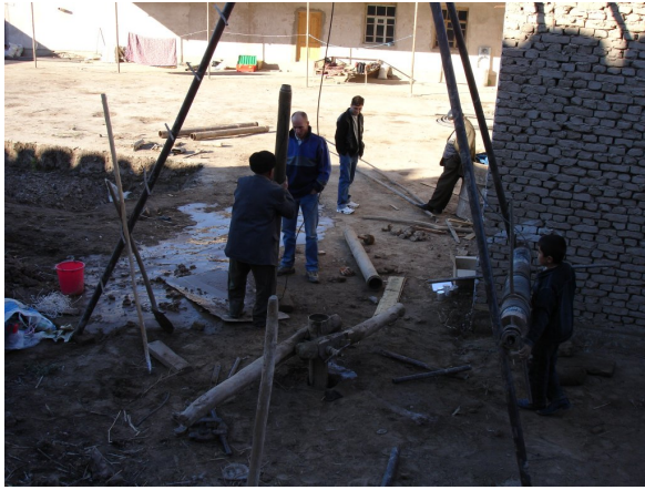
(a) Forage du piézomètre.
