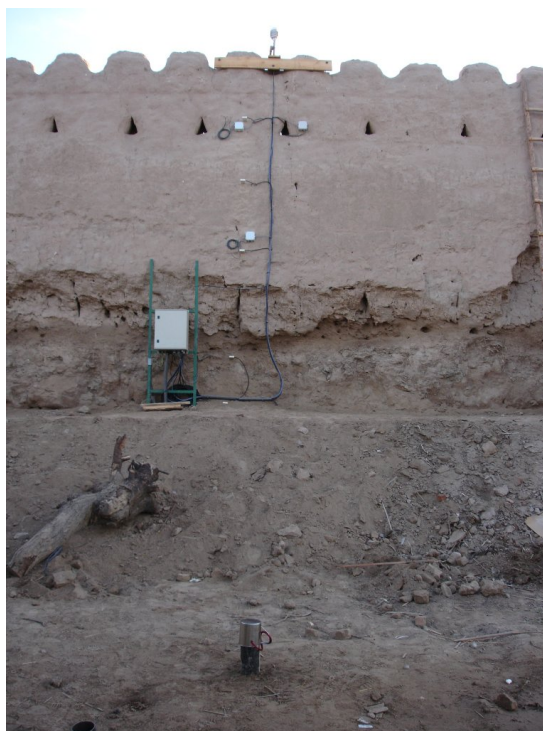
FIG. 5.1 – Photo du site installé. Au premier plan : le piézomètre. Devant le mur : le boîtier contenant le système d'acquisition. Dans le mur à différentes hauteurs : les capteurs de température et d'humidité. Au sommet du mur : la station météorologique.
