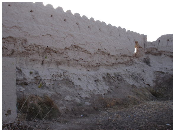
(a) Vue générale de la base du mur.
