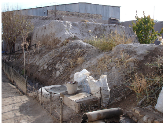
(a) Zone quasiment détruite.
