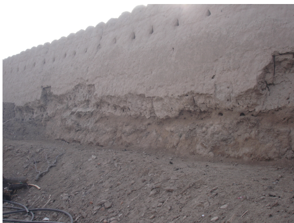
(a) Partie externe : mur de bauge.
