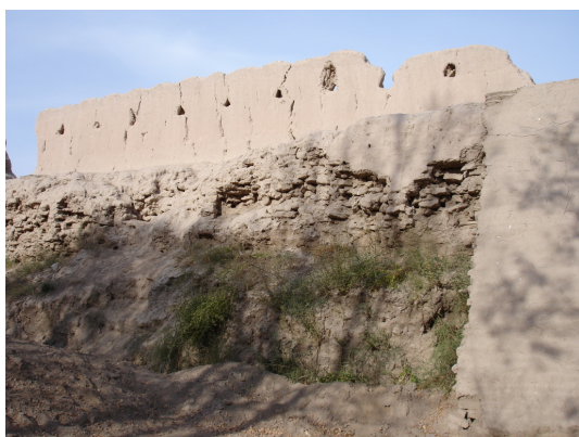
(c) Face interne de la muraille : chemin de ronde en briques.
