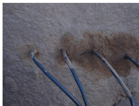
(d) Rebouchage des trous avec de la boue.
