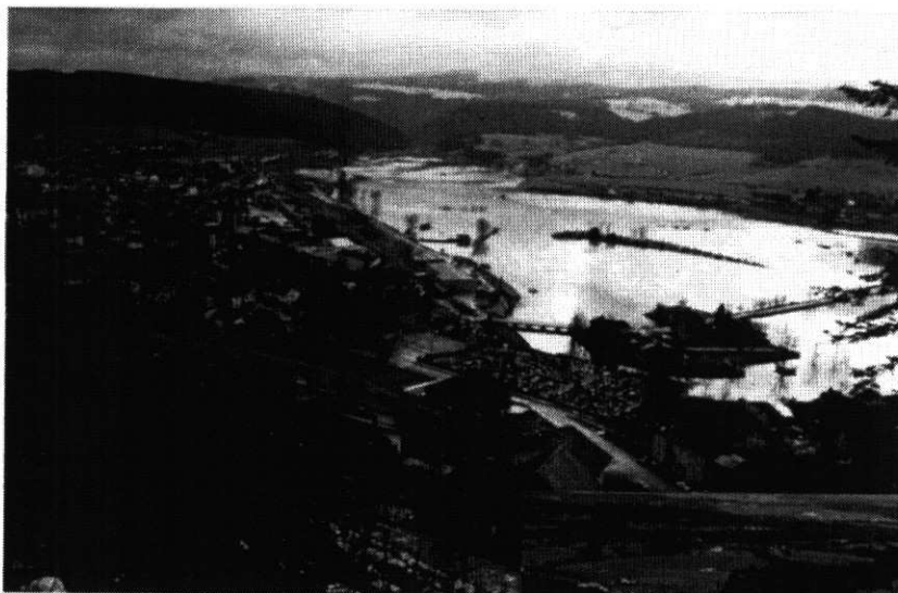
Zone amont inondée Crue de janvier 92 vue vers l'aval
