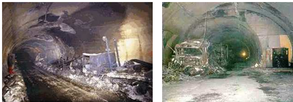
FIG. 1.2 – Tunnel du Mont Blanc entre la France et l'Italie. Le 24 mars 1999, un feu s'est déclaré dans un camion transportant de la margarine, produisant des températures atteignant 1000 °C. 39 personnes ont péri dans l'incendie.
