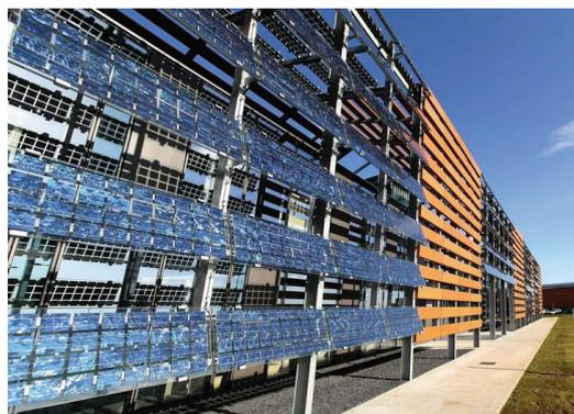
Figure 3-15. Structure Photovoltaïque intégrée en brise soleil sur le site Tenesol Toulouse.
