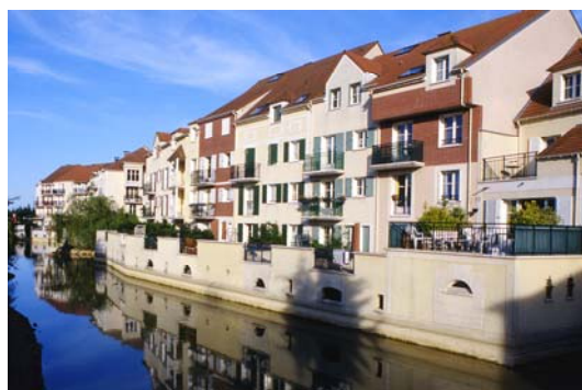
Photo 4 : Secteur 4 - Entrée de Bailly-Romainvilliers, vue du programme Apollonia
