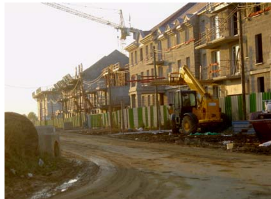
Photo 14 : Quartier en construction à Bussy-Saint-Georges
