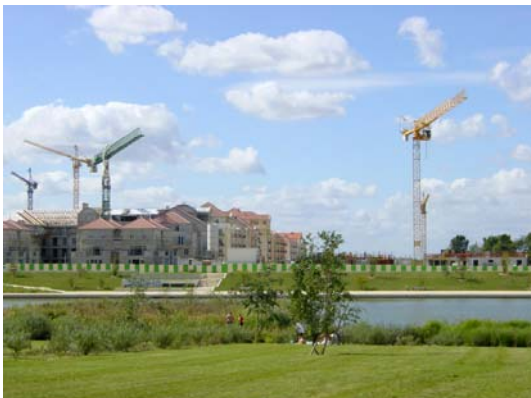
Photo 13 : Les chantiers et les grues de Bussy-Saint-Georges
