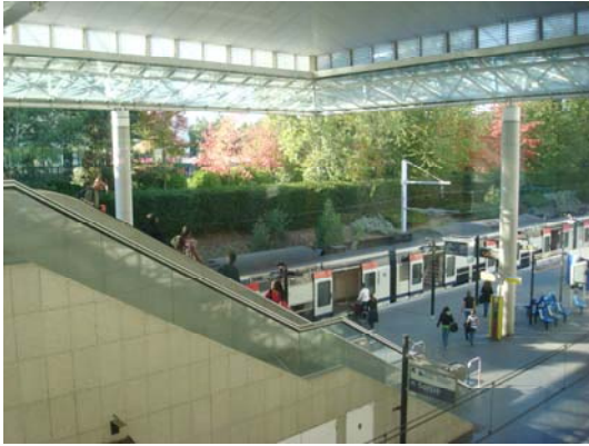
Photo 17 : La gare RER de Val d'Europe
