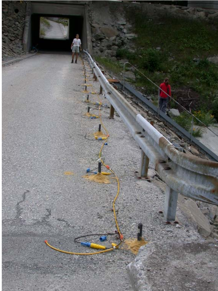
Fig. 5.15- Photographie de la mise en place du monitoring de potentiel spontané. Ce profil comporte deux flûtes de 16 électrodes Petiau chacune.
